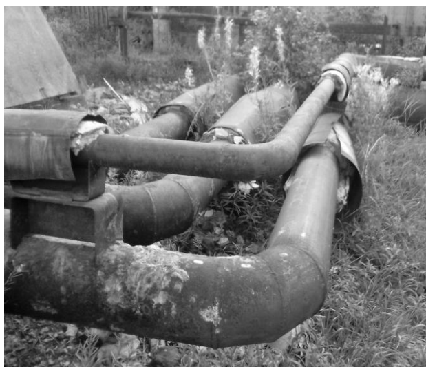
Рис.2. Состояние тепловой изоляции: а) паропровода; б) теплотрассы
