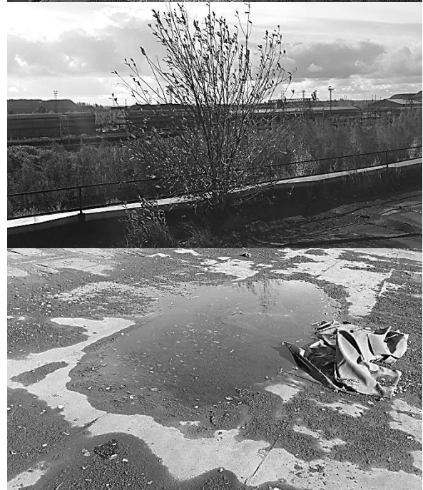
Рис. 2. Дефекты и повреждения кровельного покрытия
