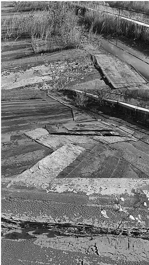
Рис. 2. Дефекты и повреждения кровельного покрытия
